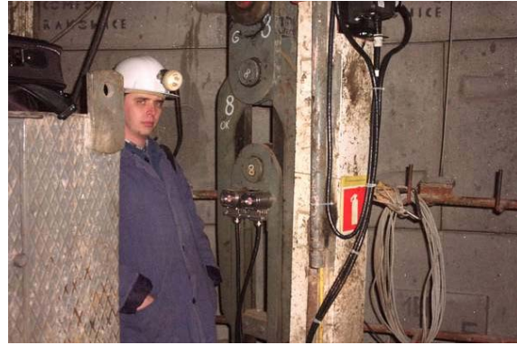
Foto 4. Wkładka pomiarowa siły w zawieszeniu linowym
